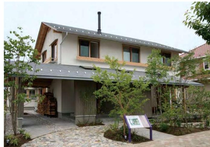
外壁は21mm厚のカラマツ材の深溝張り。凸凹の板を交互に張り合わせることで無垢材特有の反りを防ぎ、深溝の陰影で外観に豊かな表情を生む。浸透性の自然塗料で木の質感を活かし、明るいグレーカラーが都市の景観になじむスマートな外観。
