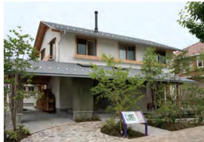
外壁は21mm厚のカラマツ材の深溝張り。凸凹の板を交互に張り合わせることで無垢材特有の反り返りを防ぎ、深溝の陰影で外観に豊かな表情を生む。浸透性の自然塗料で木の質感を活かし、明るいグレーカラーが都市の景観になじむスマートな外観。
